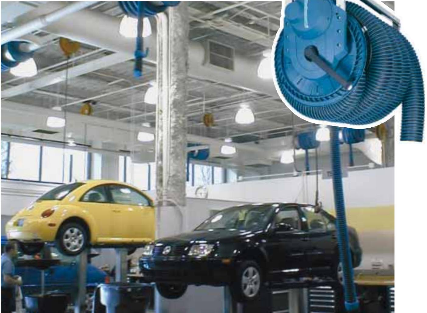
Die beste Lösung für Werkstätten mit hohen Decken, bei denen Deckenkräne zu berücksichtigen sind oder hohe Fahrzeuge durchfahren. Bedient per Handeinheit – IR-Steuerung oder Kabelfernbedienung. Ein Sensor am Aufroller gibt den Betriebsstatus an. Elektronische Grenzscharter mindern die Gefahr von Fehlfunktionen und unnötigem Schlauchverschleiß. Start/Stop des Ventilators wird automatisch gesteuert. Die Montage des Ventilators am Aufroller ist möglich.
