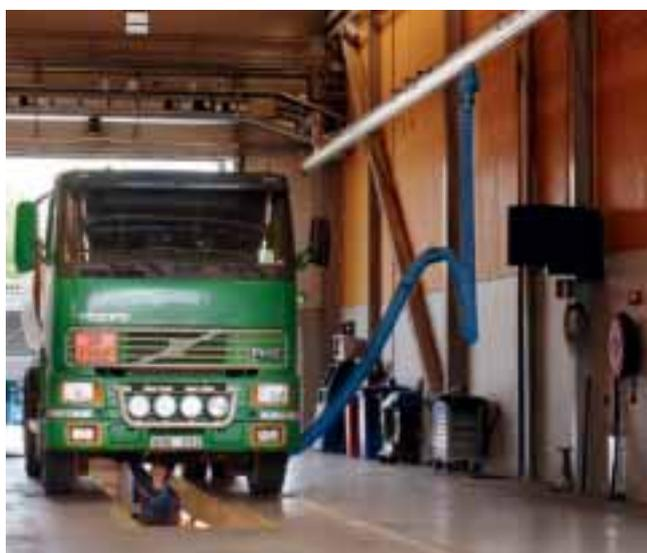
Beispiel eines Abgassystem für die Fahrzeuginspektion.
